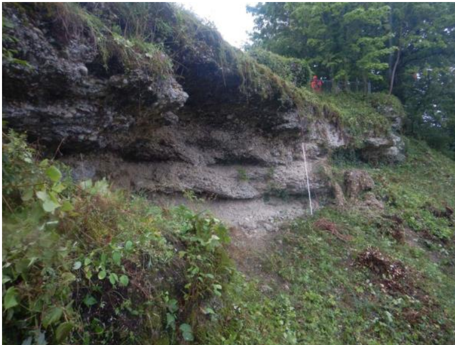
Legende: Überhängende Felswand "Südost" nach Rodung, Blick Richtung Nordwesten
