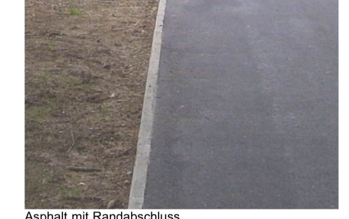
Asphalt mit Randabschluss
